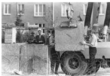
Mauerbau, Aufstellen von Betonblöcken, 1961
