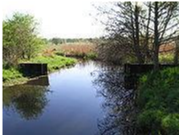
Reste der ehemaligen Gewässersperre am Tegeler Fließ im Norden von Berlin
