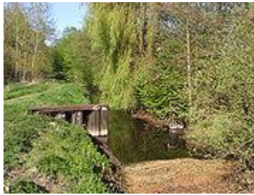
Reste der ehemaligen Gewässersperre am Kindelfließ am Nordrand von Berlin
