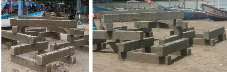
Ilustrasi 4.41: Proses pembuatan model balok beton (dok.KMPP, 2009)
