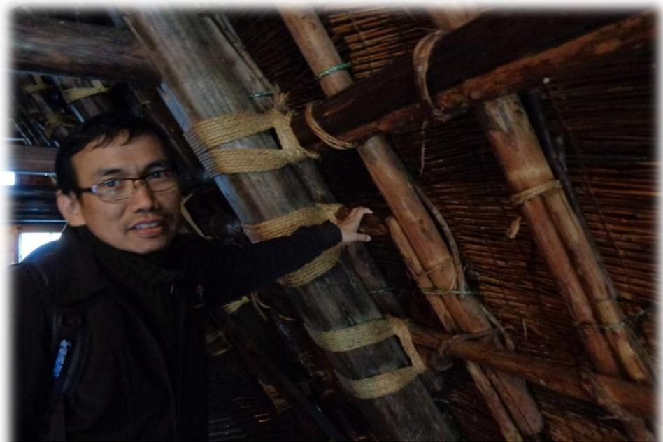
Gambar 27. Sistem ikat pada bagian atap dan rangka bangunan. Ketika terjadi guncangan baik oleh gempa maupun angin, hanya bergerak-gerak maju mundur karena diantara rangka bangunan dengan rakitan atap terdapat kayu bulat.
