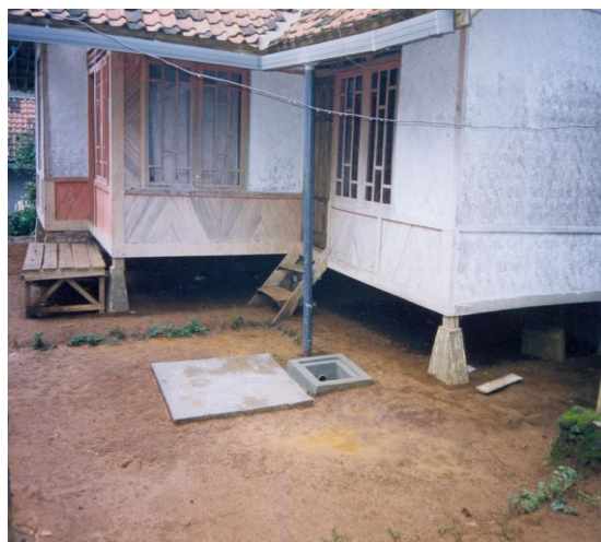
Gambar 5.7: Rumah di desa dengan sumur resapan
