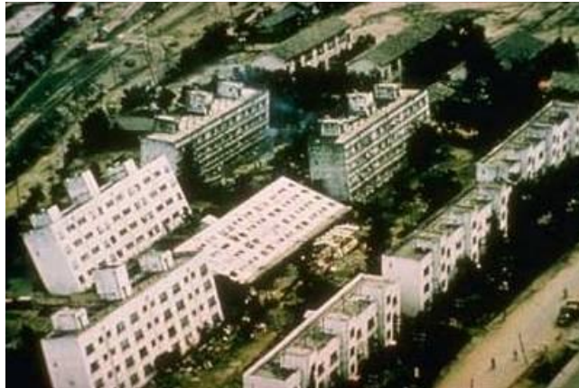
Gambar 10.15: Akibat gempa bumi telah menghancurkan berbagai fasilitas umum Sumber: google.image
