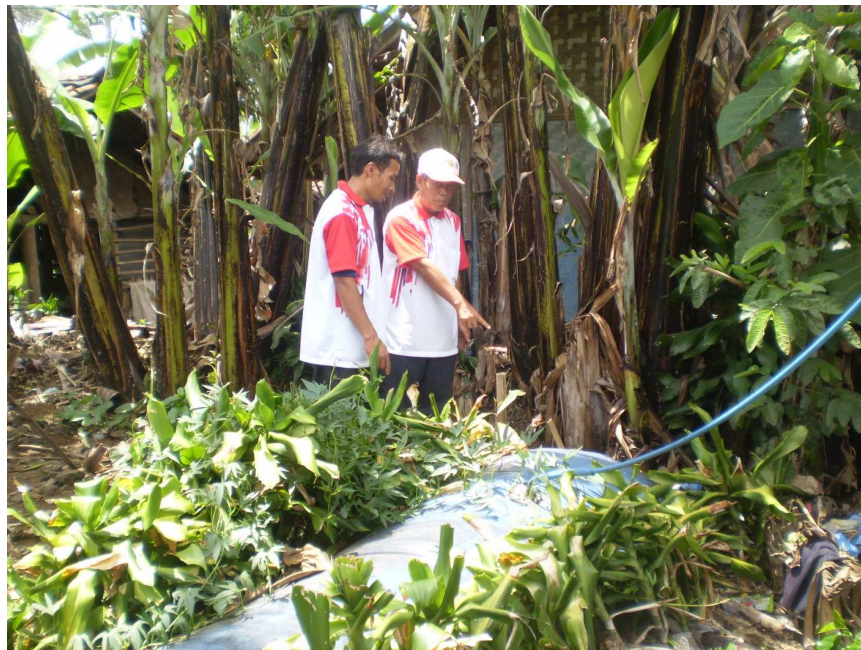
Gambar 5 Instalasi Reaktor Biogas
