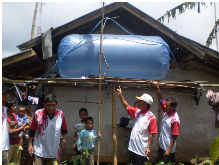
Gambar 7 Penampung Biogas sudah Terlihat Mengembung dan Mengeras
