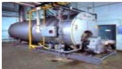
Boiler digunakan untuk menghasilkan kalor yang diperlukan untuk menaikkan temperatur minyak ataupun menjaga temperatur pada tangki dan deodorizer.
