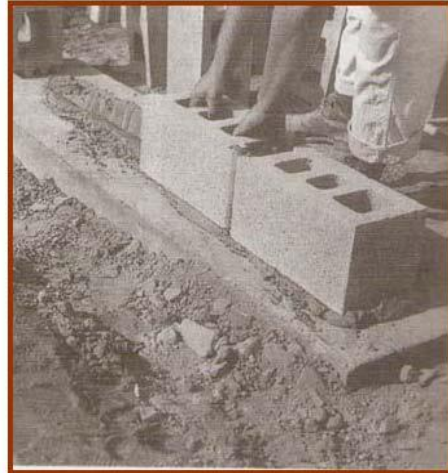
Gambar IV-19 a dan IV-19 b Menyusun dinding pasangan-batu beton: (a) Bantalan adukan ditebar pada fondasinya. (b) Lapisan-arang pertama dari blok untuk pasangan sudut-antar diletakkan di atas adukannya. Adukan untuk siar pasangan pelopor diberikan pada ujung setiap blok dengan cetok sebelum bloknya diletakkan.
