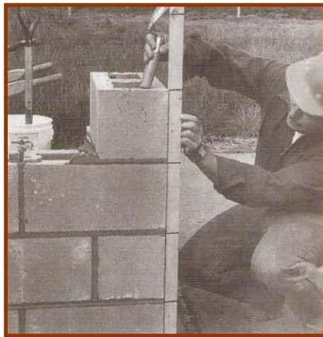
Gambar IV-19 c dan IV-19 d (c) Pasangan pelopor dibangun lebih tinggi. Adukan biasanya diberikan hanya pada cangkang muka bloknya dan tidak diberikan pada badannya. (d) Ketika setiap lapisanpasangan dibentang, tingginya secara teliti diperiksa entah menggunakan mistar lipat, atau, seperti yang ditunjukkan di sini, batang-ukur tingkat yang ditandai dengan tinggi setiap lapisan-pasangan.
