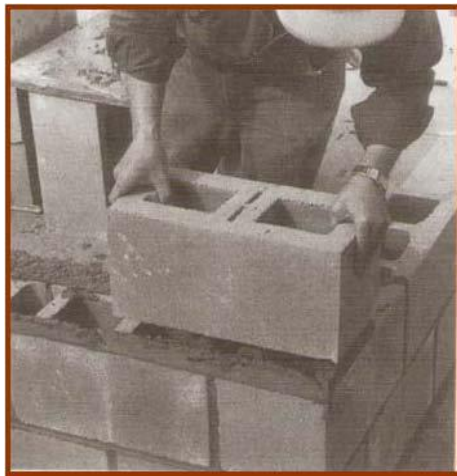
Gambar IV-19 c dan IV-19 d (c) Pasangan pelopor dibangun lebih tinggi. Adukan biasanya diberikan hanya pada cangkang muka bloknya dan tidak diberikan pada badannya. (d) Ketika setiap lapisanpasangan dibentang, tingginya secara teliti diperiksa entah menggunakan mistar lipat, atau, seperti yang ditunjukkan di sini, batang-ukur tingkat yang ditandai dengan tinggi setiap lapisan-pasangan.
