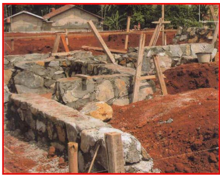
Gambar IV-5, Aplikasi Pondasi Batu Kali di Lapangan
