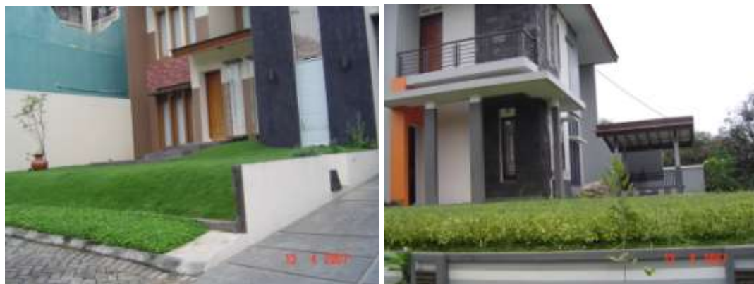
Gambar 4.6. Dua rumah di perumahan menengah besar Gading Regency, dengan halaman yang terbuka tanpa pagar, hanya mengolah permainan ketinggian lahan (kontur). Teras yang
