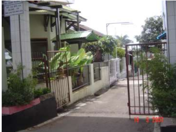
Gambar 4.11. Sebuah jalur ( path ) berupa jalan kecil ( gang ) di perumahan Sarijadi yang dipasang pintu pagar. Sebuah teritorialitas arsitektur yang menguatkan perasaan aman dan meningkatkan pengawasan ( surveillance ) teritori, tapi sekaligus mengurangi relasi dan interaksi sosial.
