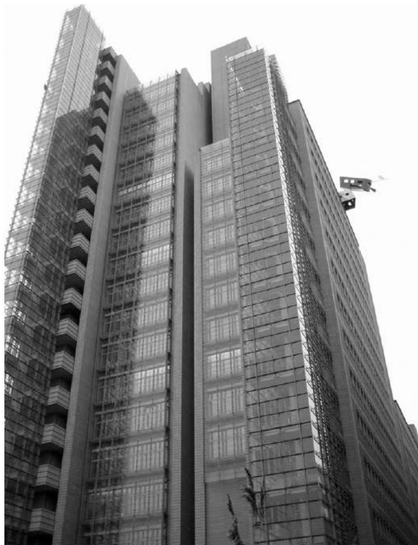
Gambar 3.8. Tangga darurat sebagai elemen arsitektural. Renzo Piano's Debis Building di Berlin menggunakan tangga darurat untuk memperkuat artikulasi fasade bangunan.
