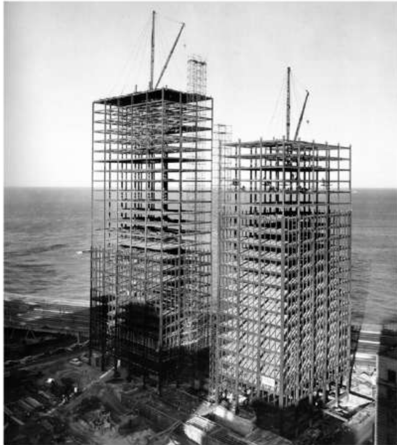
Gambar 4.14. Struktur rangka adalah system struktur yang sering dipakai untuk bangunan tinggi. Mies van de Rohe adalah arsitek pelopor penggunaan sistem struktur rangka untuk Lake Shore Drive Apartment (1949).
