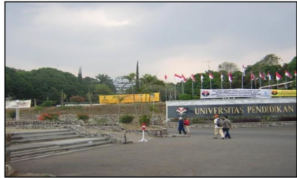
Pembangunan UPI yang mengakibatkan peningkatan suhu, debu dan kebisingan di daerah gerbang utama
