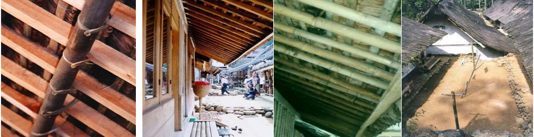
Struktur atap pada rumah Kampung Naga
