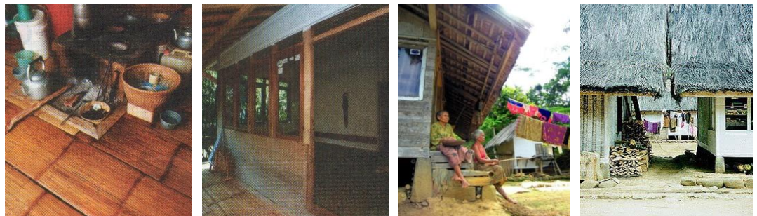
Lantai terbuat dari kayu albasia. Penutup atap menggunakan ijuk
