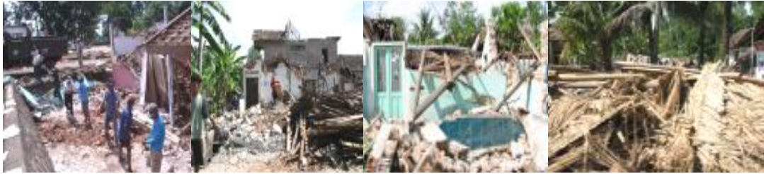
Gambar I.4. Akibat Gempa Terhadap Bangunan
