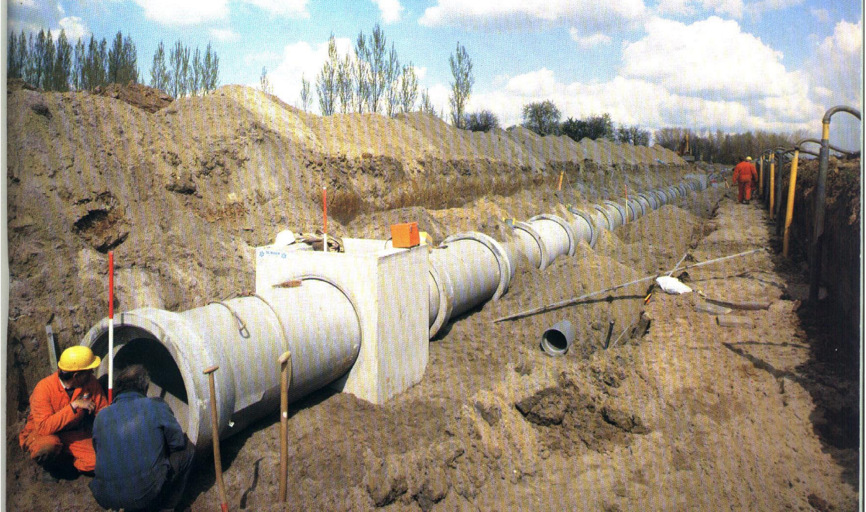
Gbr. 1 Pemasangan pipa riol lingkungan
