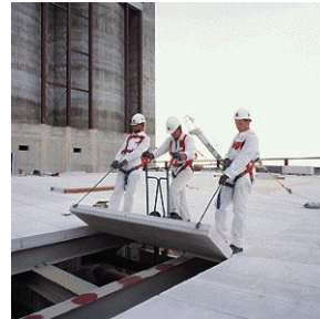
Gbr 21 Pengeringan pada panel lantai hebel
