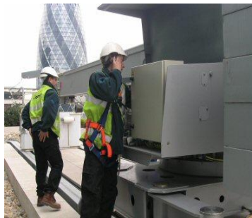
Gbr. 7 Pengecekan bagian-bagian tertentu pada bangunan
