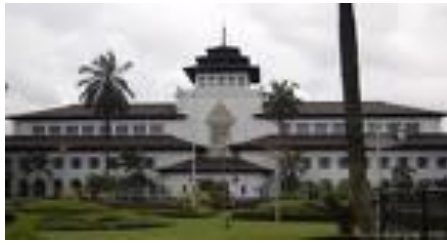
Gbr. 1 Bangunan Gedung Sate sebagai tempat pusat Pemerintahan
