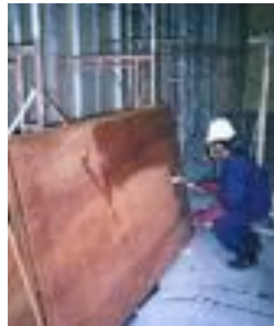
Gbr. 12 Pengecatan kayu sebagai bagian pemeliharaan konstruksi
