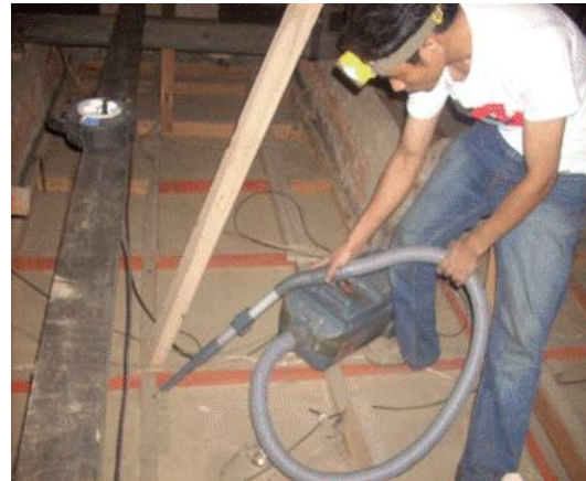
Gbr. 15 Pemeliharaan berkala plafon & struktur atap untuk deteksi dini rayap kayu kering, perawatan kabel-utilitas, untuk kesehatan penghuni. Sekitar 55 % masalah berat pada bangunan datang dari atap, dan cenderung tak
