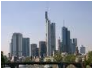
Gbr. 3 Bangunan Gedung sebagai tempat kegiatan usaha
