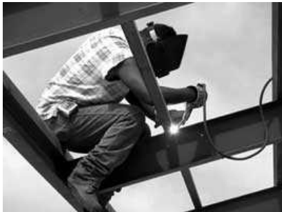
Gbr. 9 Perawatan pada konstruksi bangunan (plafon)
