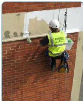
Gbr 6. Perawatan pada dinding bangunan
