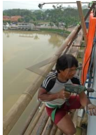
Gbr. 10 Perawatan berkala pada bangunan Irigasi Cisadane Tangerang
