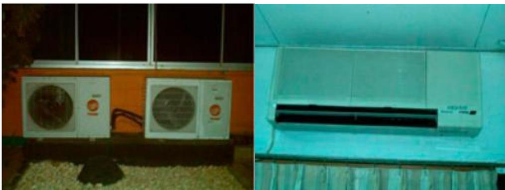
(Gambar 1. Mesin AC jenis Direct Expantion / Ekspansi Langsung)
