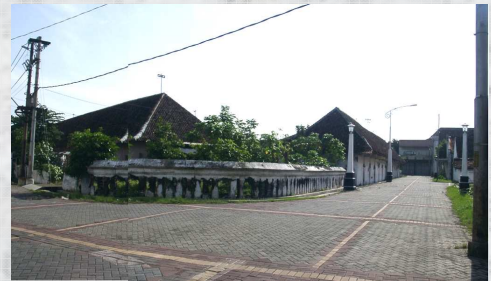
Jl. Garuda dari arah barat tapak tampak dari selatan
