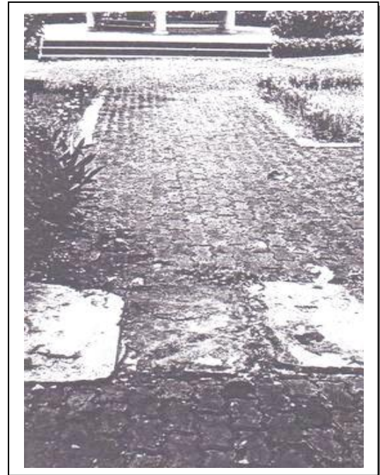
Gambar 6. Paving Blok selain dapat membantu peresapan air hujan. Permukaannya yang kasar dan berongga dapat menghambat limpasan air hujan
