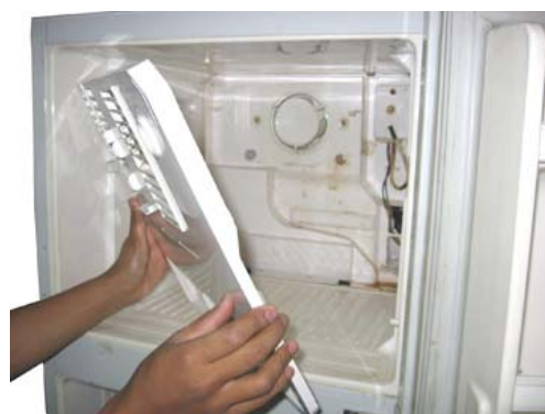
Gambar 4.17 Melepas ventilasi
